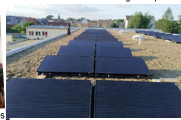
Installation panneaux photovoltaïque aux écoles
