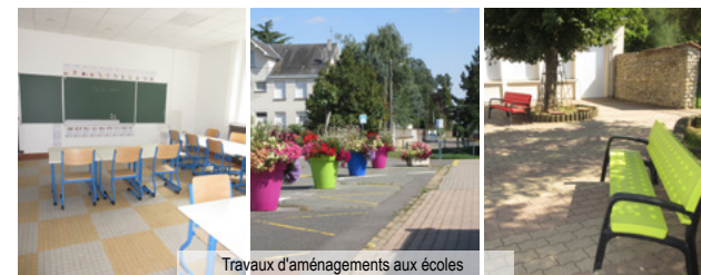
Travaux d'aménagements aux écoles
